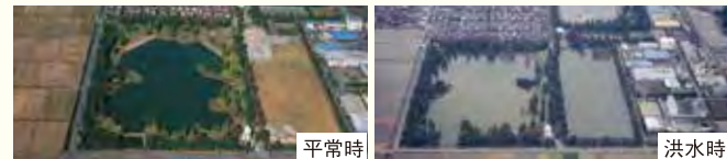
開発調整池(松伏調整池)
