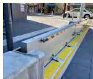
浸水防止壁の設置(市川市)
