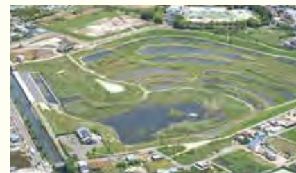
市川市 大柏川第一調節池
